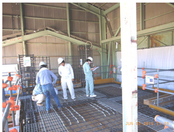
【配筋検査実習の様子】
